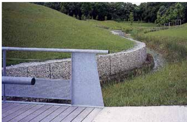
Le gabion particulièrement bien adapté aux espaces humides Un mur gabion en accompagnement d'une noue ou bassin de rétention participe à l'enrichissement de la biodiversité et véhicule une image de qualité environnementale.
