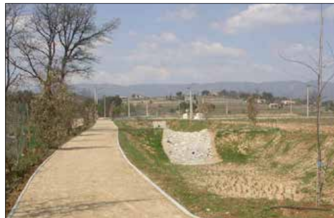
Cheminement doux et bassin de rétention Parc du Revol à la Tour d'Aigues Le bassin met à distance les limites des lots d'une promenade qui traverse et relie des habitations à la campagne environnante. La ZAE maintient ainsi des usages pour tous.
